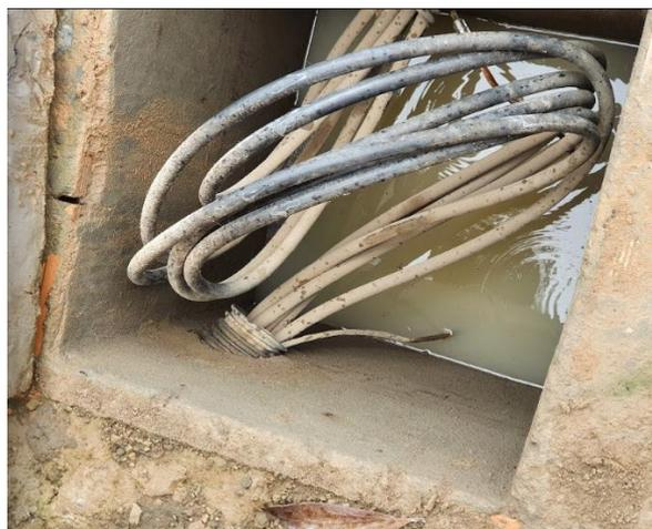
*Figura 6 - Caixa de passagem inundada*
