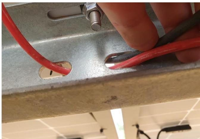
Figura 3 - Cabos CC com a isolamento gasta durante a passagem pelos dutos
