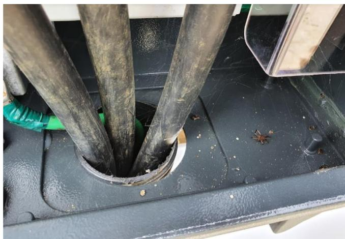
*Figura 8 - Falha na vedação da entrada para cabeamento CC de um inversor*
