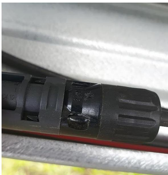
*Figura 5 – Par de conectores CC de fabricantes diferentes*
